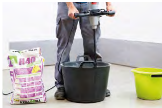
PREPARE THE ADHESIVE CEMENT · Prepara el cemento de agarre · Préparer le ciment à prise rapide · Bereiten Sie den Klebemörtel vor
