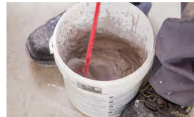
PREPARE THE GROUT · Prepara el material de rejuntado · Préparer le matériel de joint · Rühren sie das fugenmaterial an
